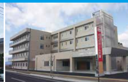
特別養護老人ホームさくらホーム天童新築工事
