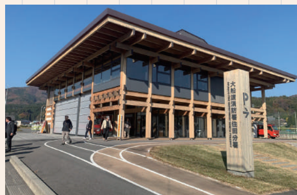
住田分署の躯体は、県産の杉の柱と唐松の梁の貫式ラーメン構造
