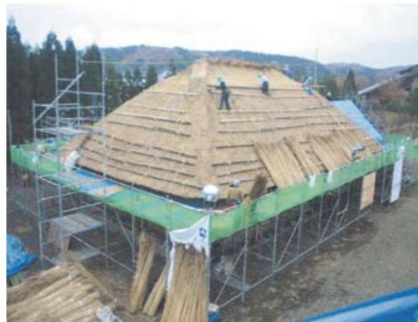
茅葺作業状況
