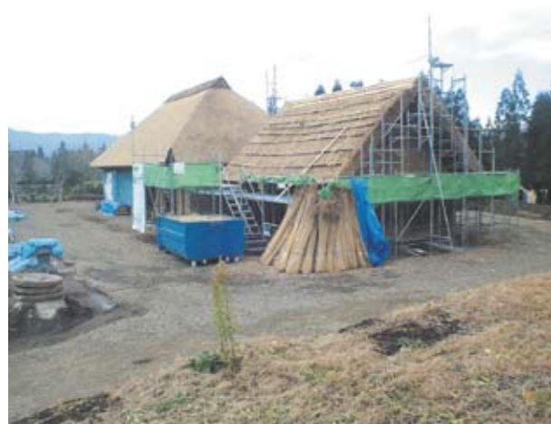
釜房の家復元工事全景
