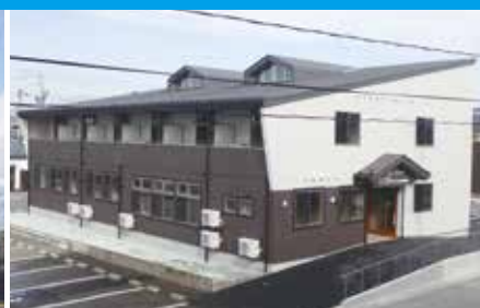
東根小規模多機能施設新築工事 ケアセンターとこしえ さくらんぼ東根駅前
