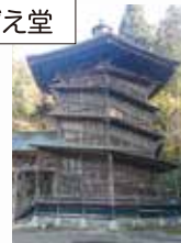
六角三層の らせん路 通路階段の お堂
